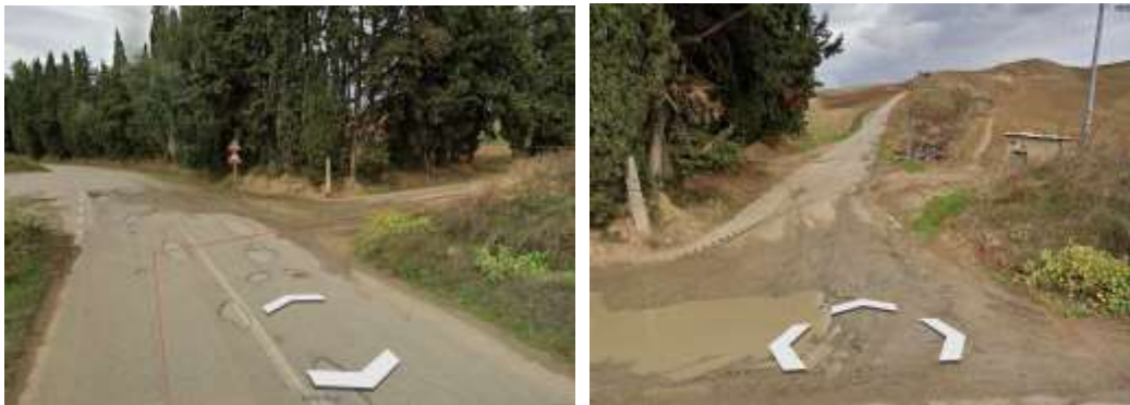
Figura 26 – Viabilità di accesso al sito impianto – Strada vicinale
