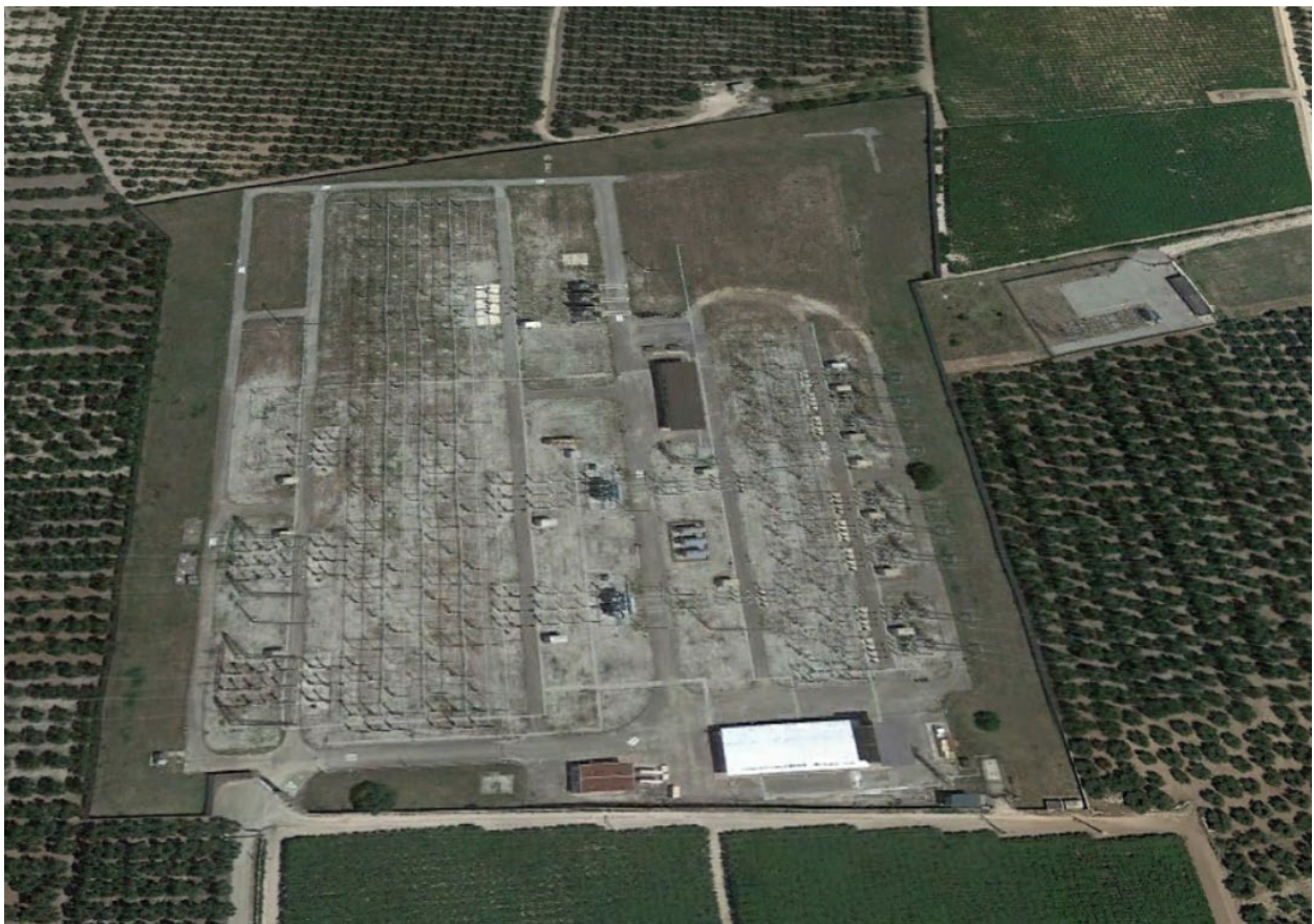
Figura 28 – Stazione Elettrica di Terna S.p.A. ad Andria.
