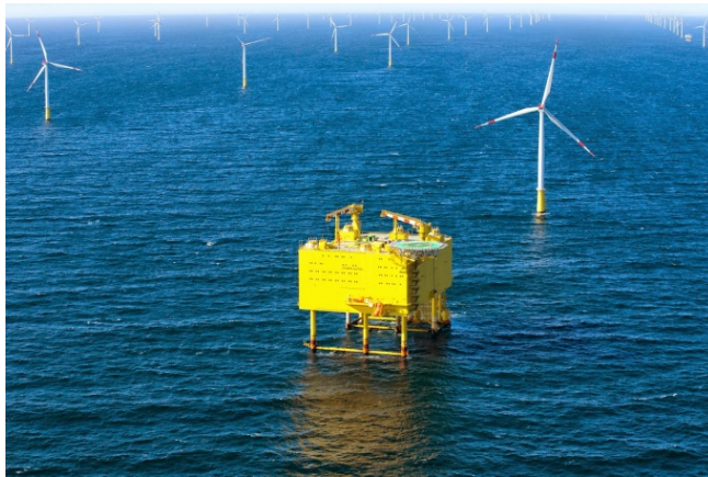
Fig. 11, 12 - Sottostazione elettrica offshore HVDC
