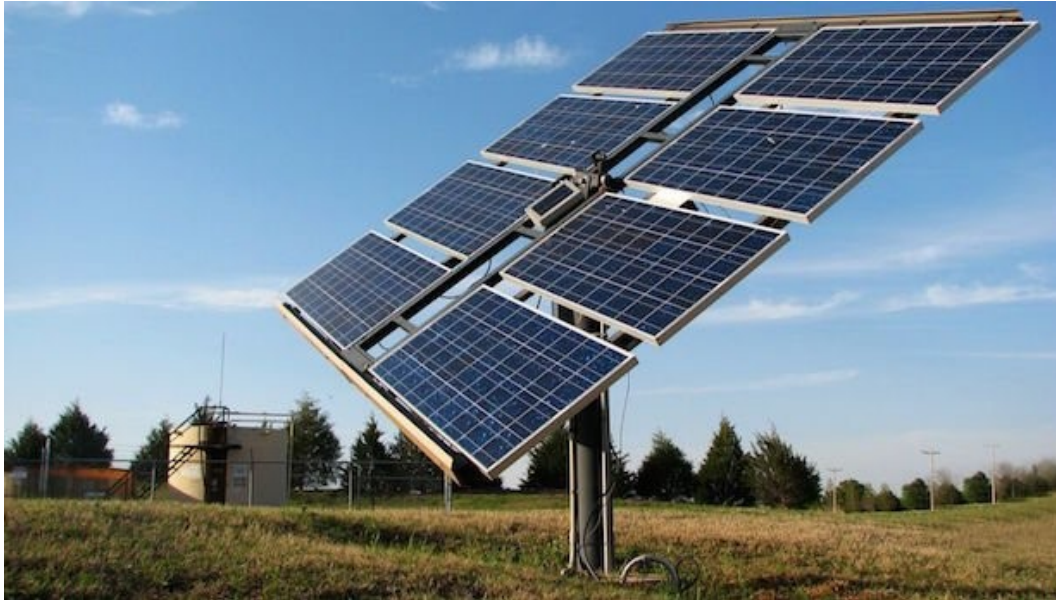
Figura 41 - Inseguitori monoassiali di "azimut"
