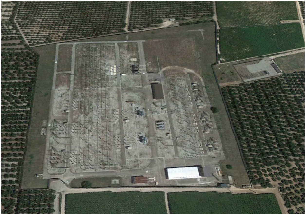
Figura 28 – Stazione Elettrica di Terna S.p.A. ad Andria.
