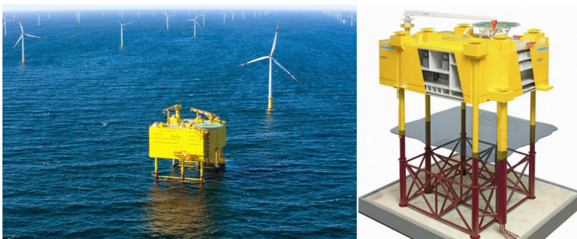
Figura 22 – Stazione HVDC di trasformazione 66/500 kV.
