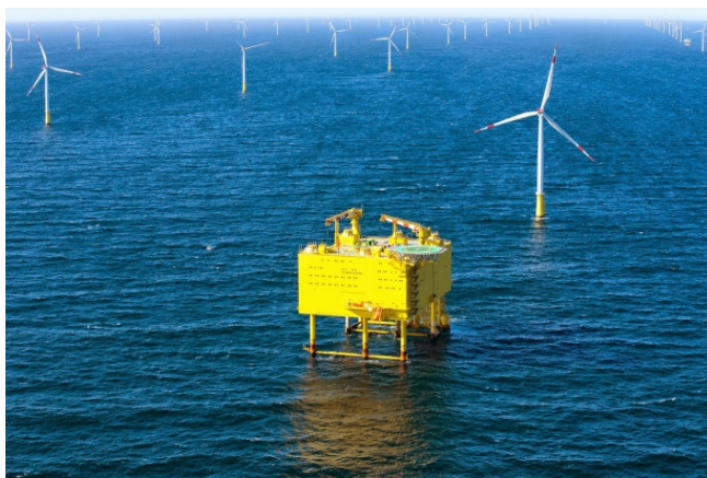
Fig. 11, 12 - Sottostazione elettrica offshore HDVC.
