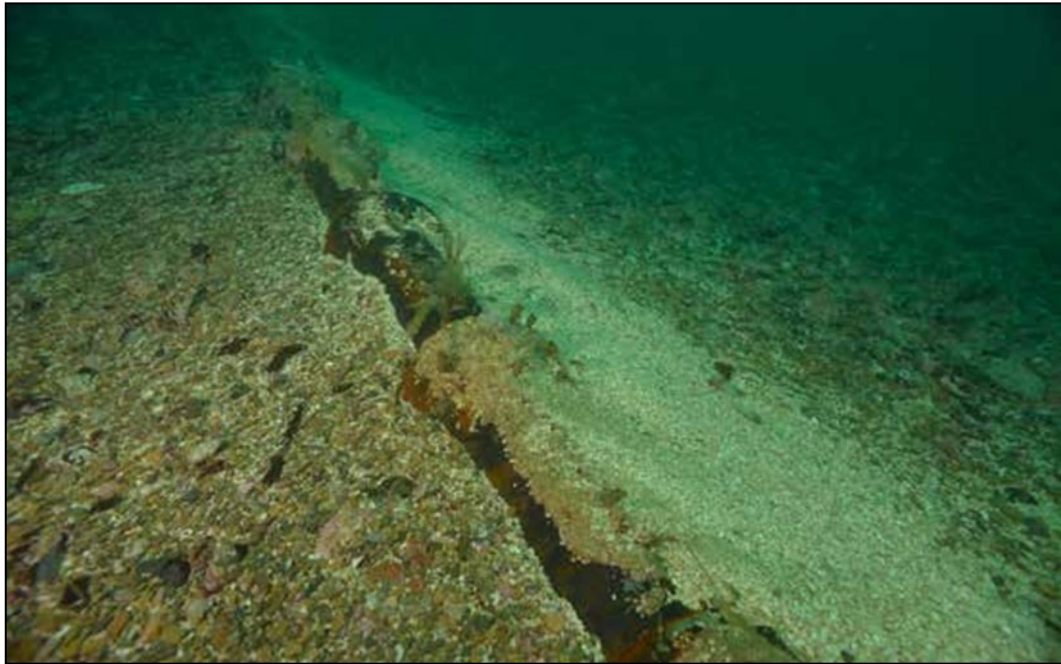
Figura 11: Esempio di accumulo di detrito sul cavidotto (da Normandeau et al., 2011)
