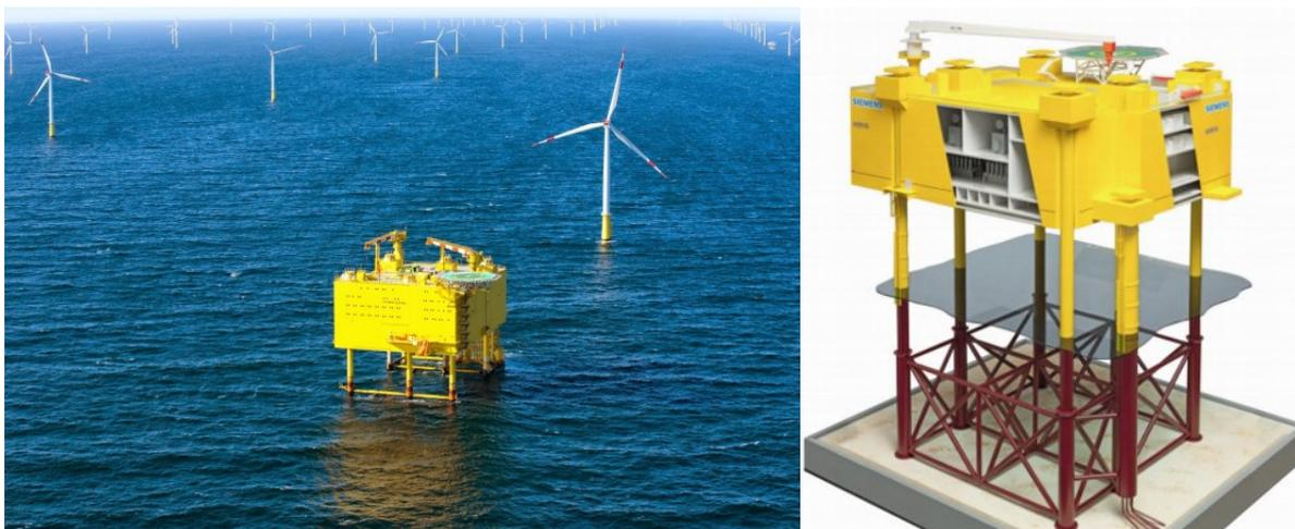
**Figura 8 – Stazione HVDC di trasformazione e conversione 66/500 kV**
