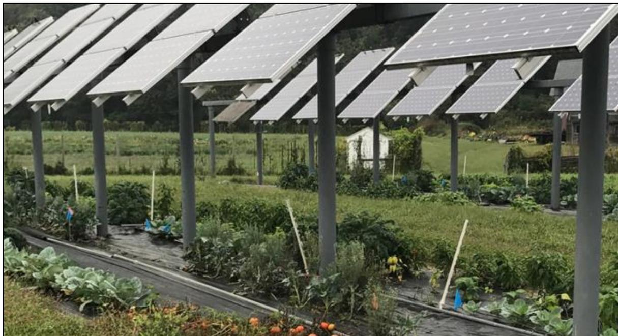
**Figura 5.2. Agrovoltaico a moduli fissi con struttura a falde in Cina, in un campo coltivato a bacche di Goji**
