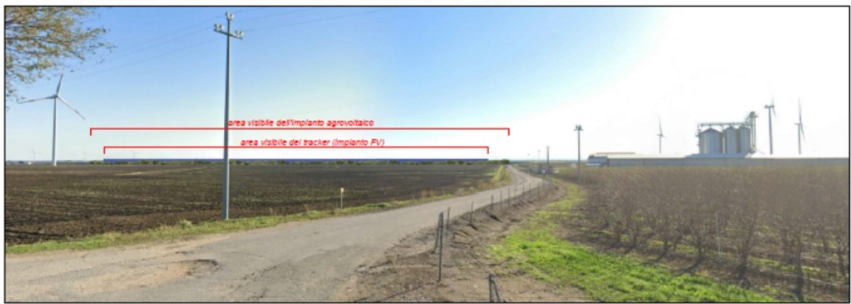
PUNTO DI PRESA 01 (dall'accesso alla Masseria "Coppa del vento" sulla strada SP25) - FOTOINSERIMENTO POST OPERAM
