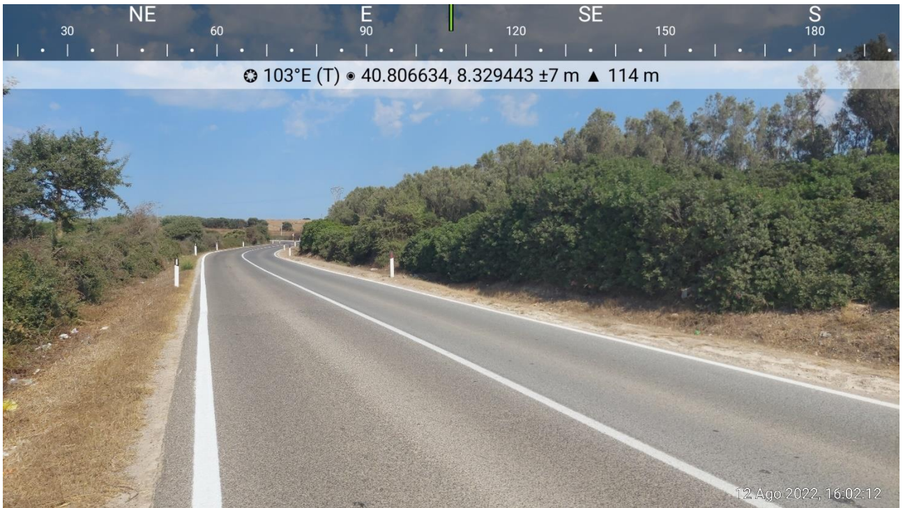
Figura 35 - Fasce alto-arbustive lungo la SP 24
