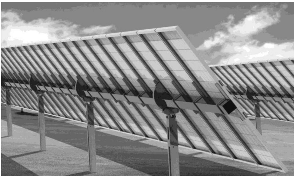
Figura 4: tracker: inseguitore monoassiale.
