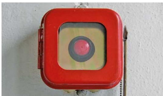
Figura 1.8: Pulsante di sgancio per apertura DG cabina
