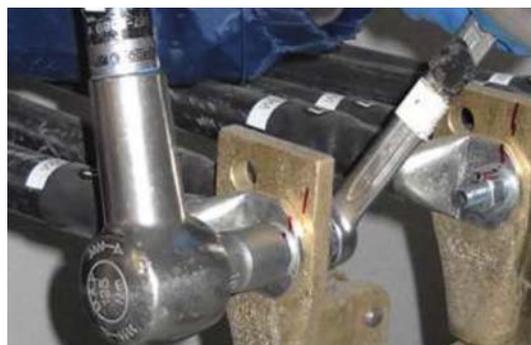
Figura 4.12: Stato di serraggio delle connessioni
