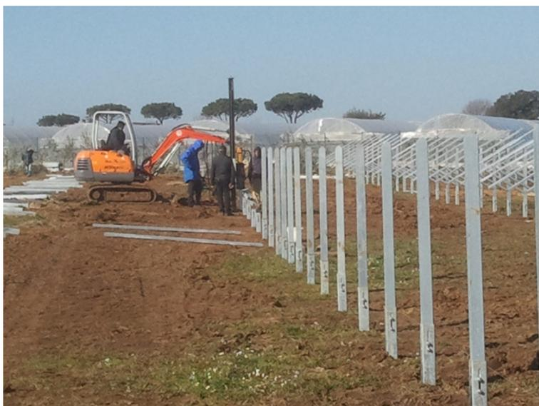
**La tipologia di ancoraggio a Sostegni Infissi risulta la soluzione ambientalmente più compatibile nella fase di dismissione in quanto, una volta rimossi, non lasciano alcuna traccia residua della loro presenza.**
