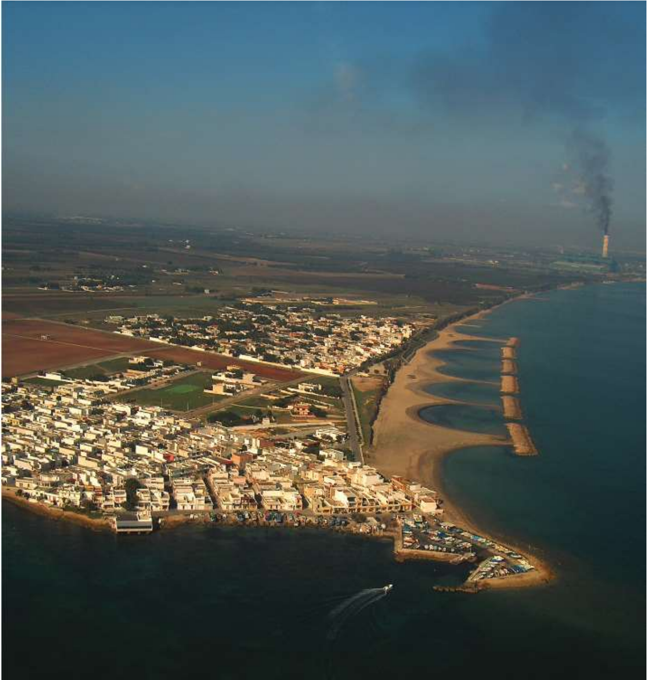
La Centrale Termoelettrica "Federico II" vista da sud dalla localit  "Campo di Mare"
