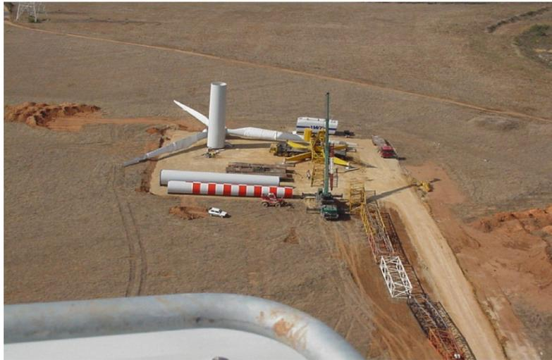
Figura 10 –Piazzola per il montaggio dell'aerogeneratore
