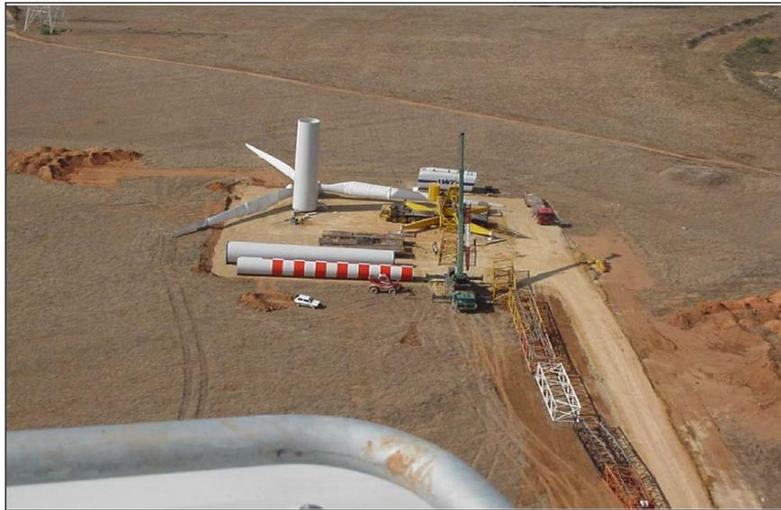
*Foto 1. Piazzola per il montaggio dell'aerogeneratore*
