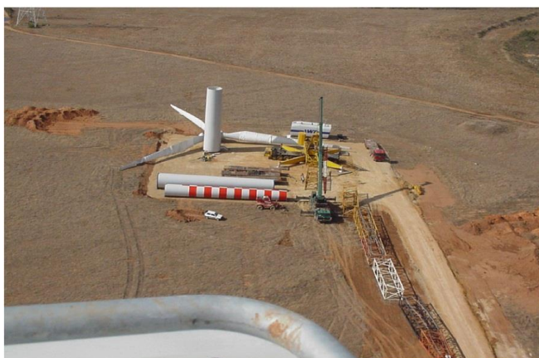
Figura 1 – Piazzola per il montaggio dell'aerogeneratore
