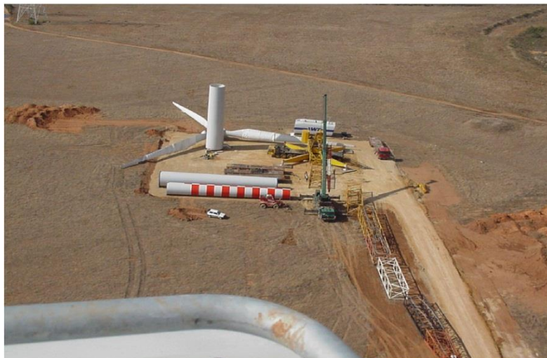
Figura 2 – Piazzola per il montaggio dell'aerogeneratore
