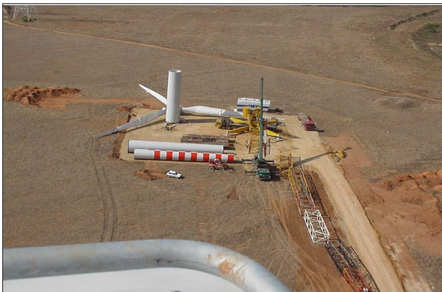
Foto 1. Piazzola per il montaggio dell'aerogeneratore
