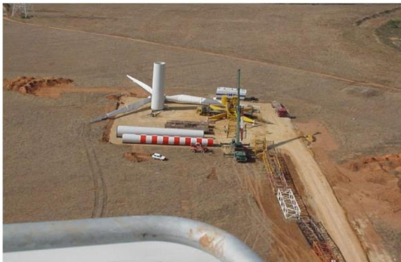
Figura 19 – Piazzola per il montaggio dell'aerogeneratore
