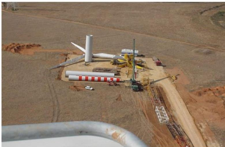
Figura 8 – Piazzola per il montaggio dell'aerogeneratore
