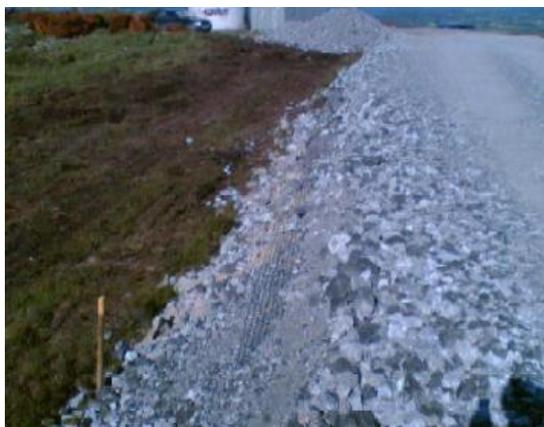
Figura 15: Superficie stradale in misto stabilizzato e drenaggio
