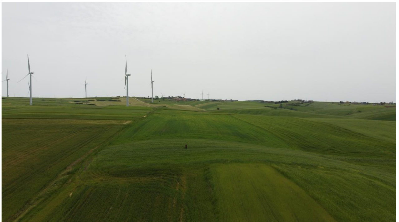
Figura 4 - Area di sedime piazzola aerogeneratore SAB03
