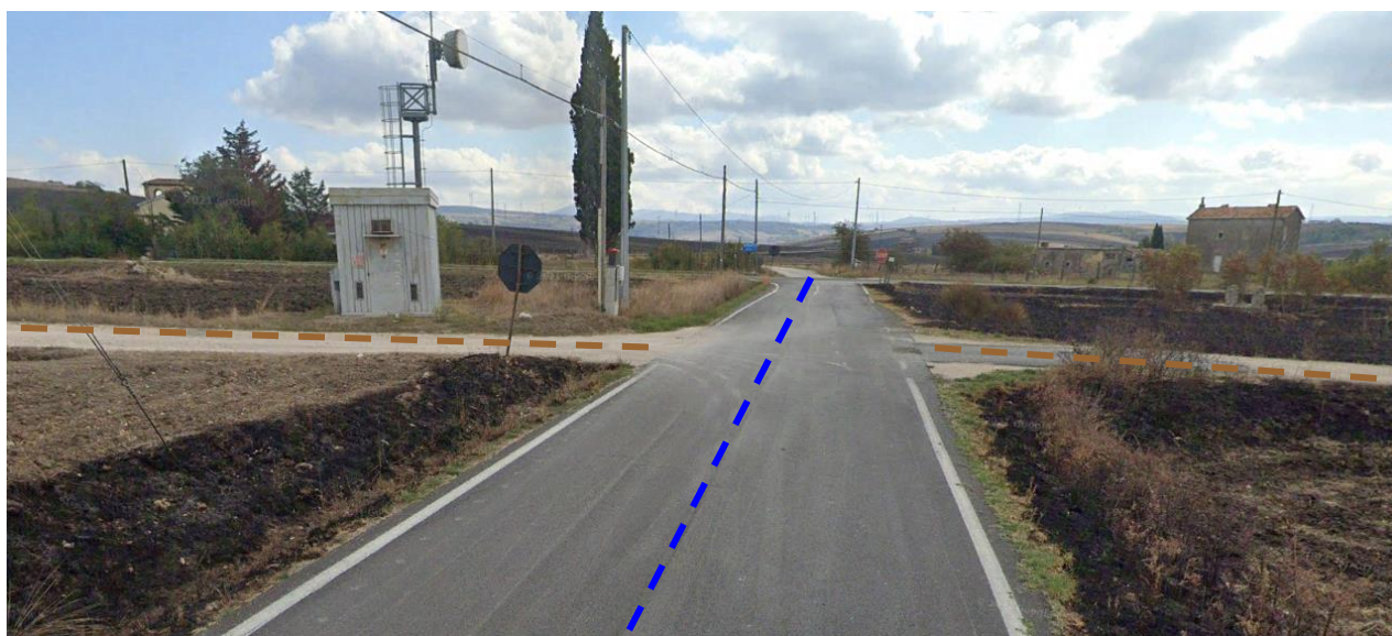
Figura 34. Attraversamento del cavidotto sul tratturo. In blu il cavidotto in TOC mentre in marrone il tratturello che attraversa perpendicolarmente la strada
