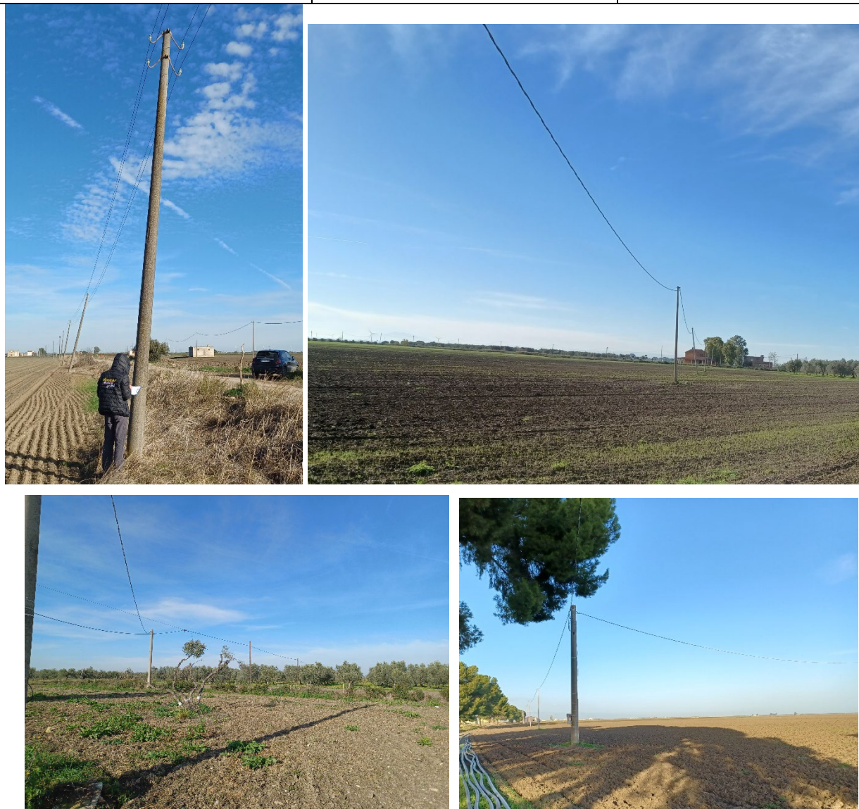
Figura 45 - Dettagli su pali BT oggetto di demolizione
