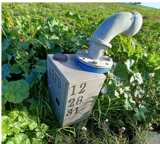
Figura 61: Foto di dettaglio su manufatto idraulico in corrispondenza del limite del Lotto 5. (Coordinate: 41° 26.951'N, 15° 40.957'E)
