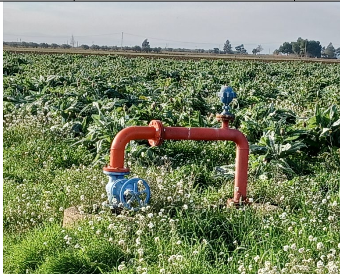
Figura 62: Foto di dettaglio su manufatto idraulico in corrispondenza del limite del Lotto 5.
