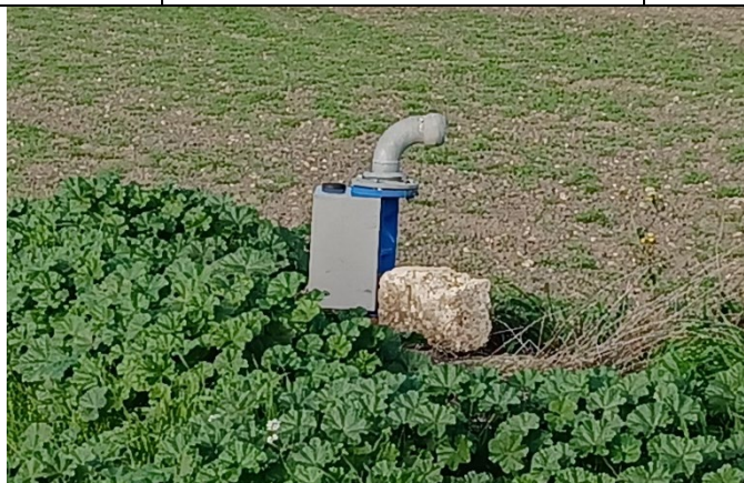
Figura 59: Foto di dettaglio su manufatto idraulico in corrispondenza del limite del Lotto 5. (Coordinate: 41° 26.725'N, 15° 41.203'E)
