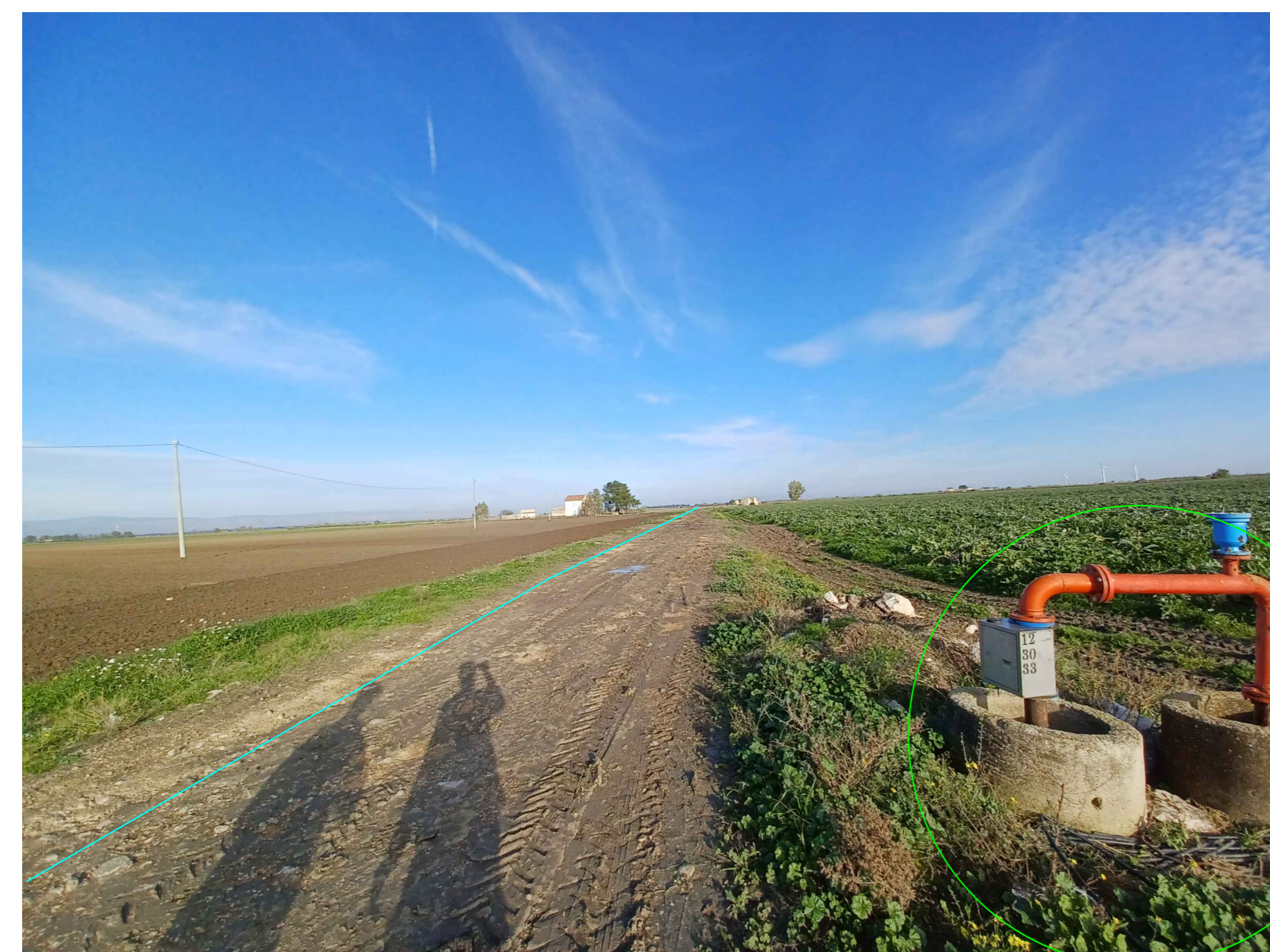
INTERFERENZA: Parallelismi o incroci con servizi idrici e irrigui interrati (da verificare in fase esecutiva) - Esempio 1
