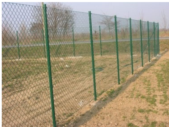
Figura 4 – Tipologico recinzione di progetto
