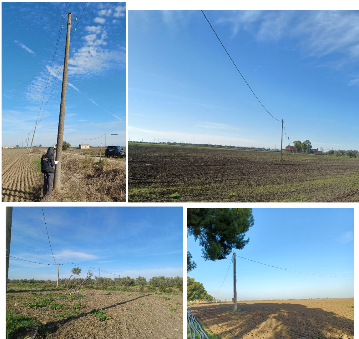
Figura 6 - Dettagli su pali BT oggetto di demolizione
