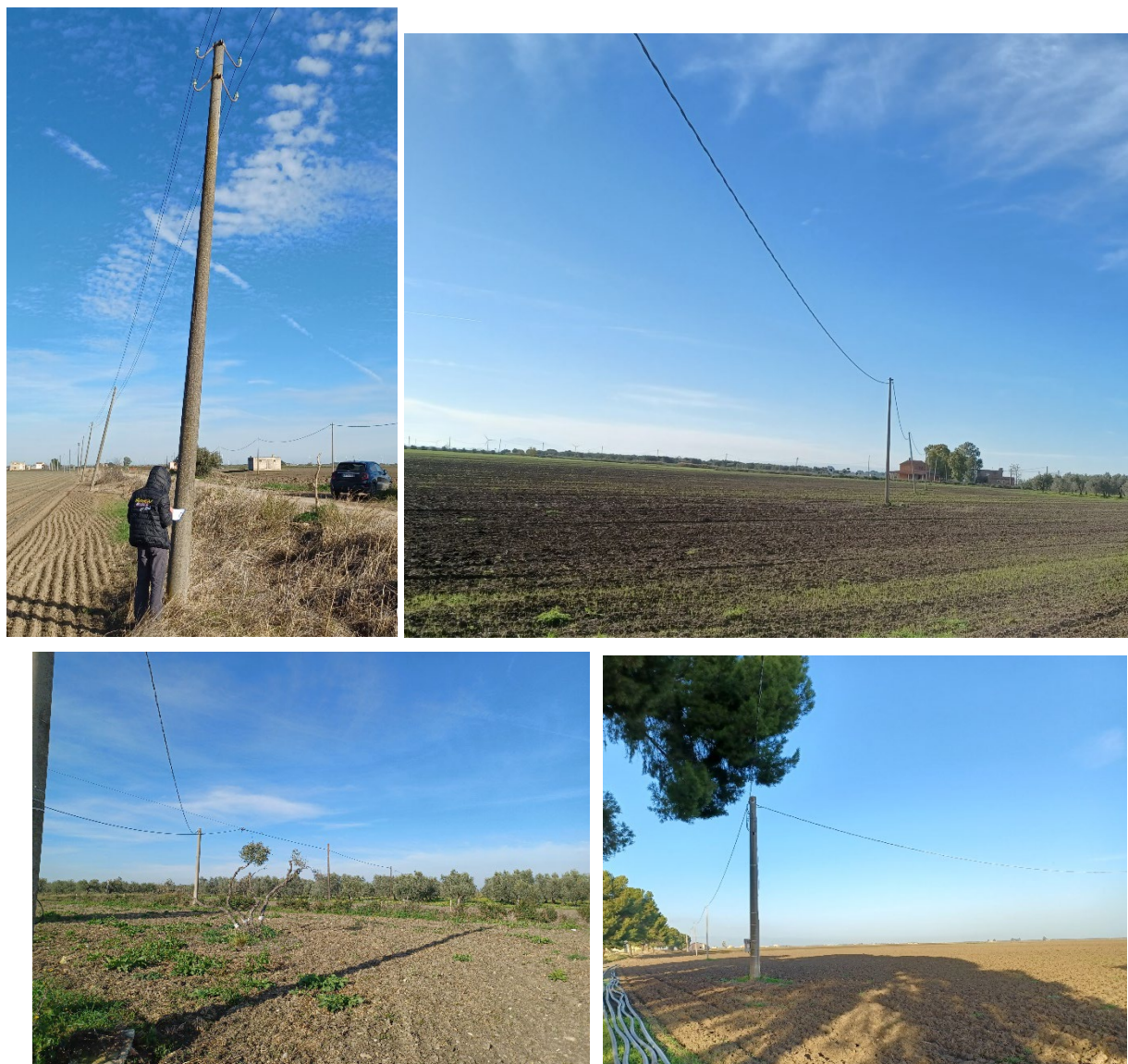
Figura 6 - Dettagli su pali BT oggetto di demolizione
