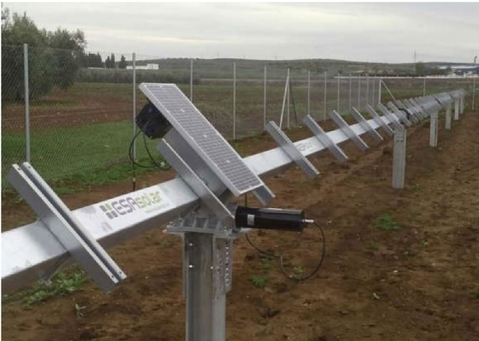
Fig.3 Predisposizione dei pali e ancoraggio delle strutture in acciaio di sostegno ai moduli fotovoltaici
