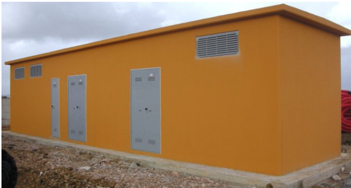
Fig.5 Posizionamento di una delle cabine elettriche
