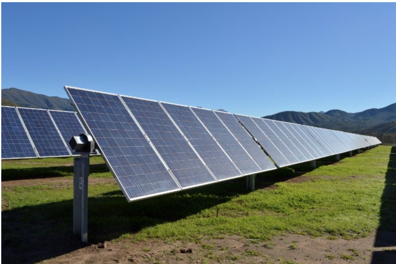
Fig. 6 Disposizione dei moduli fotovoltaici sui tracker
