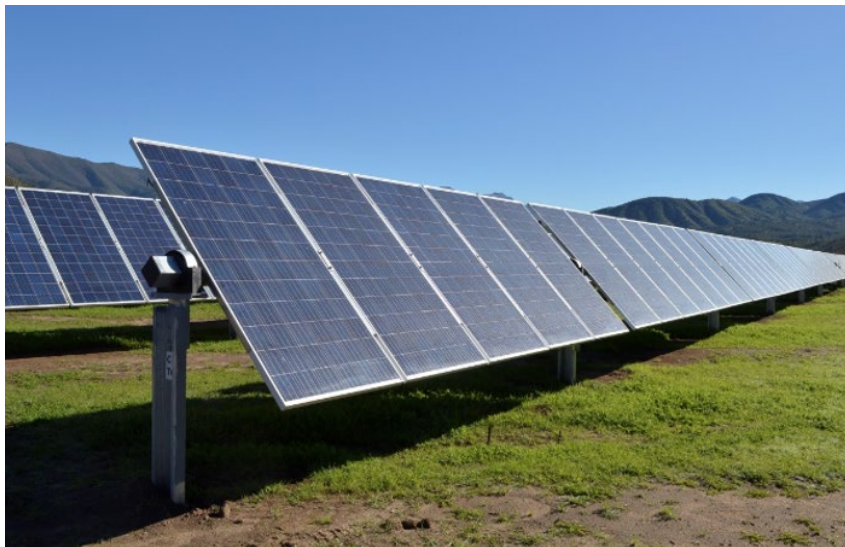
Figura 65 – Predisposizione dei moduli sui tracker
