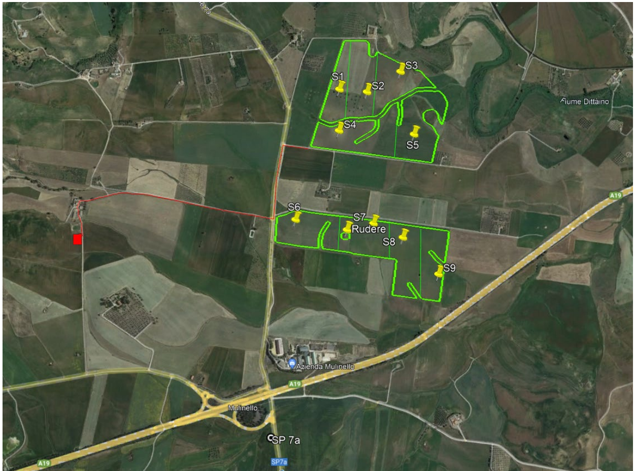
Figura 6 – Vista aerea dell’area in esame con indicazione delle infrastrutture presenti
