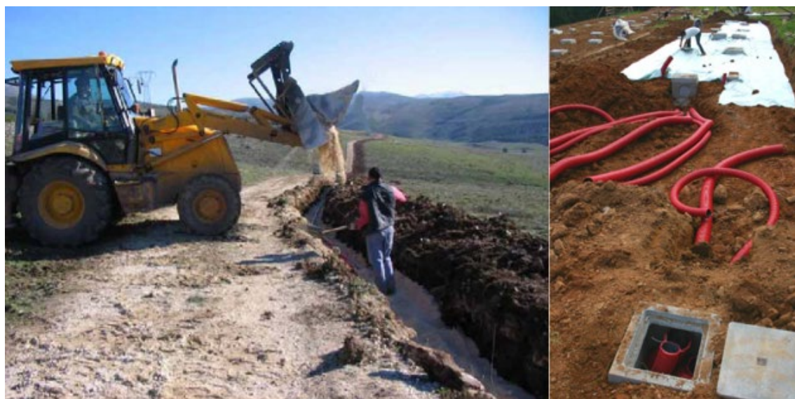
Figura 64 – Esempio di scavo e posa cavi
