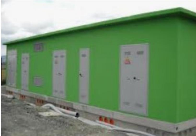
*Figura 25 – Esempio di cabina prefabbricata con fondazioni gettate in opera*
