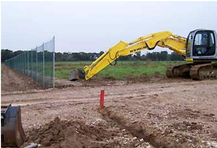
*Figura 21 – Esempio di predisposizione della recinzione perimetrale*
