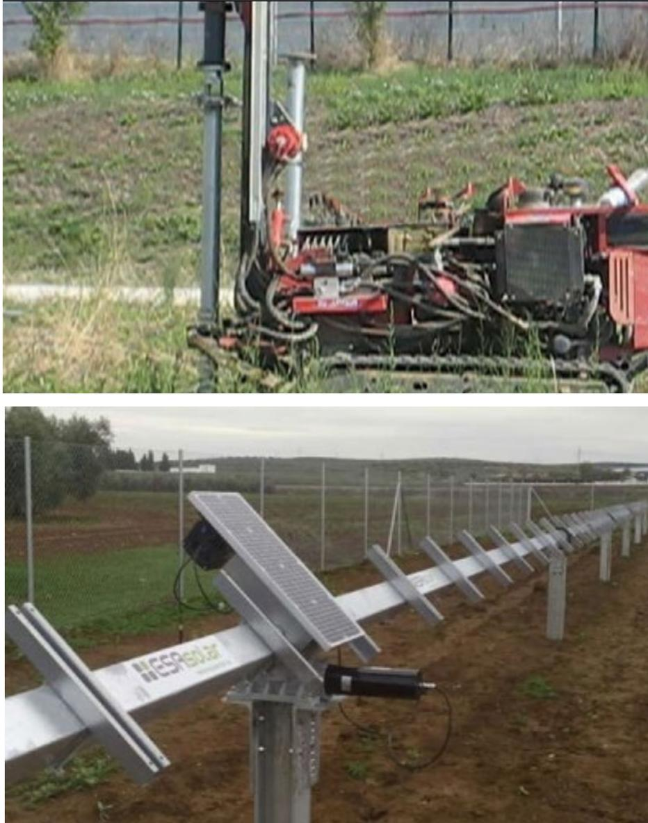
*Figura 22 – Esempio di posa del palo di fondazione*
