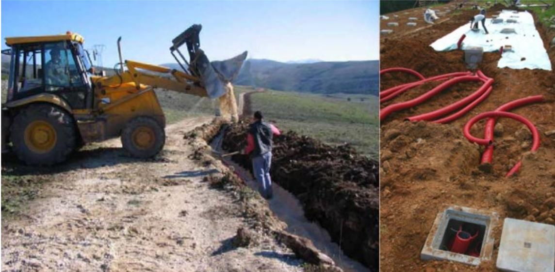
*Figura 23 – Esempio di scavo e posa cavi*
