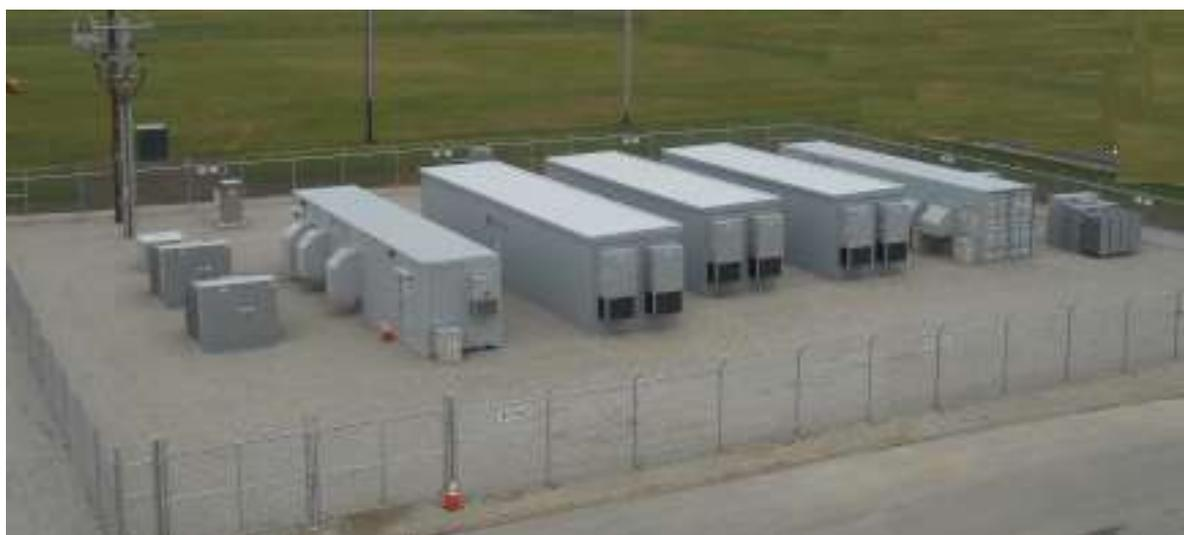
Figura 7– Sistemazione tipo area di accumulo
