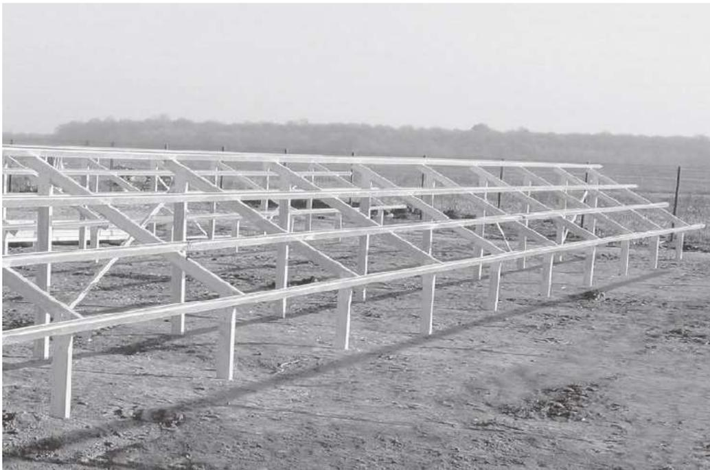
**Figura 4 – Struttura fissa**
