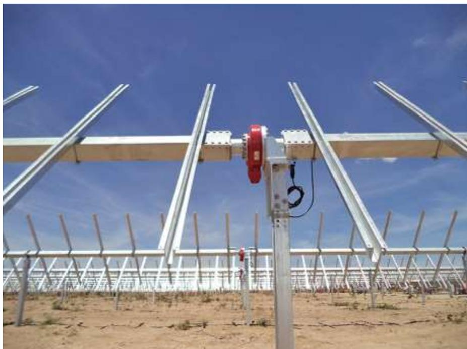
**Figura 2 – Struttura dell'inseguitore solare monoassiale**
