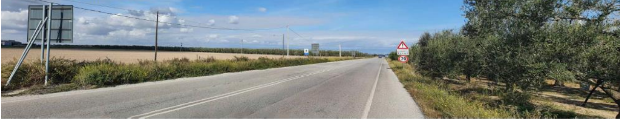
Punto di presa 2: Panoramica stato dei luoghi
