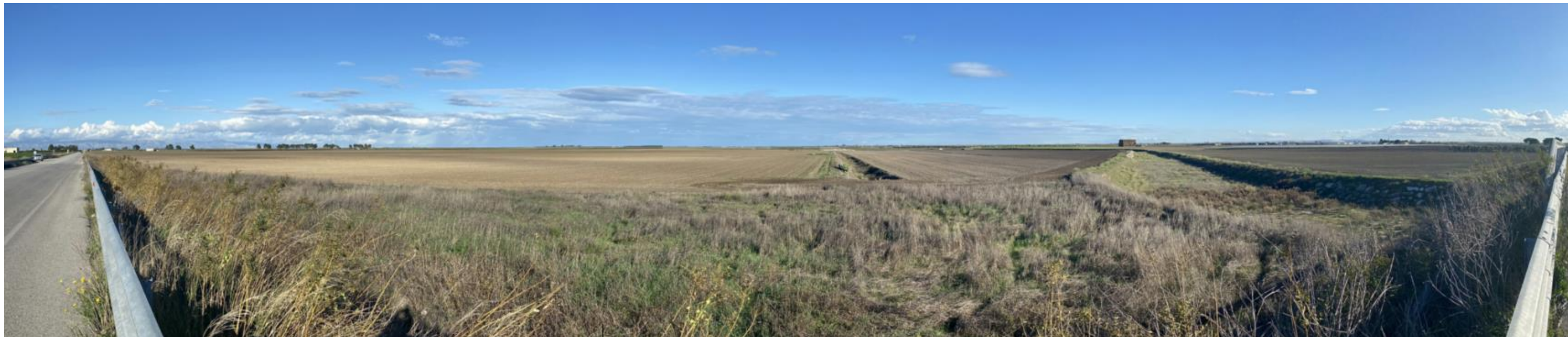
Stato di fatto – Punto di presa P9
