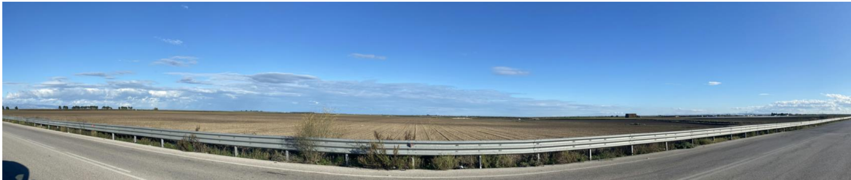
Stato di fatto – Punto di presa P10
