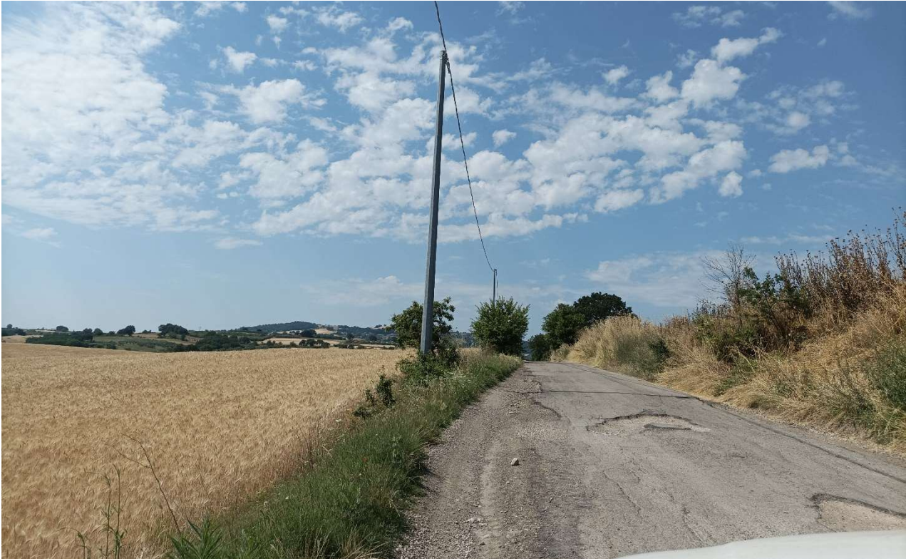
Vista strada Guardola verso la WTG_05
