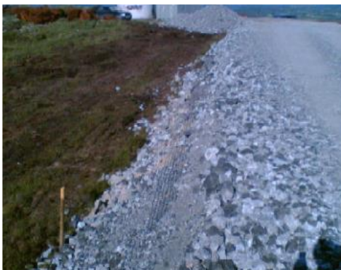
Figura 11: Superficie stradale in misto stabilizzato e drenaggio
