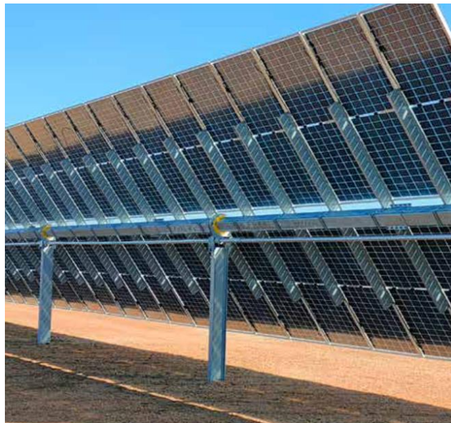
Figura 4 – Particolare Inseguitori mono assiali (Est-Ovest)
