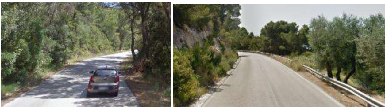
Figura 31 - SP 53 nel tratto centrale all'interno verso il valico del lupo
