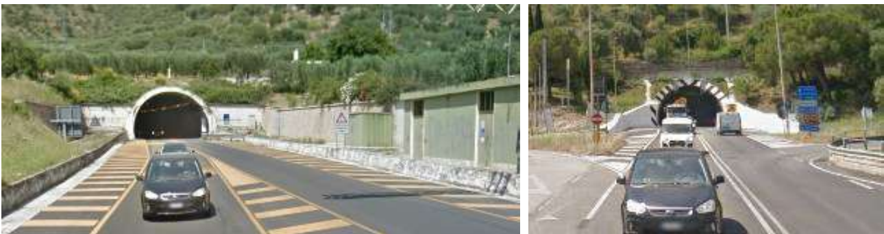
Figura 32 - SP 53, imbocco della Galleria Palombari e svincolo per Mattinata successivo alle gallerie
