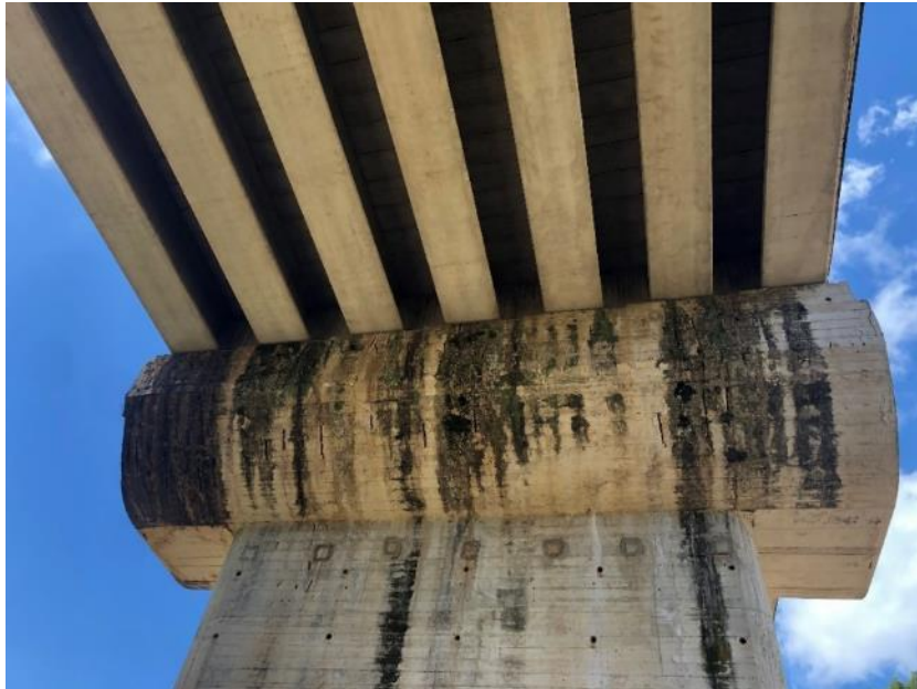
Figura 4-68: Particolare travi impalcato
