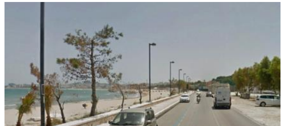
Figura 4-28: Tratto urbano in ingresso alla città di Vieste
