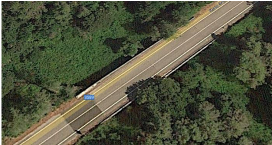
Figura 4-46: Viadotto a 2 campate
