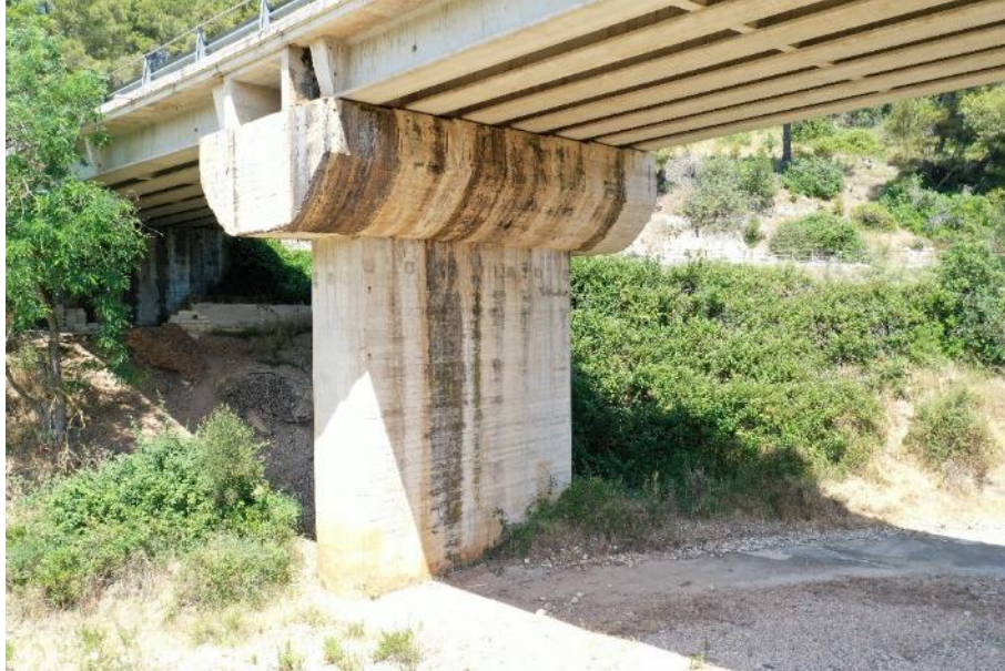
Figura 4-69: Particolare pila e pulvino
