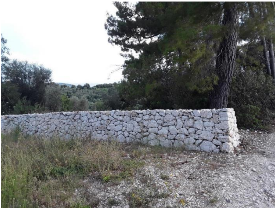
Figura 4-94 "Muretti a secco", (Foto ns elaborazione, scattata in fase di monitoraggio)
