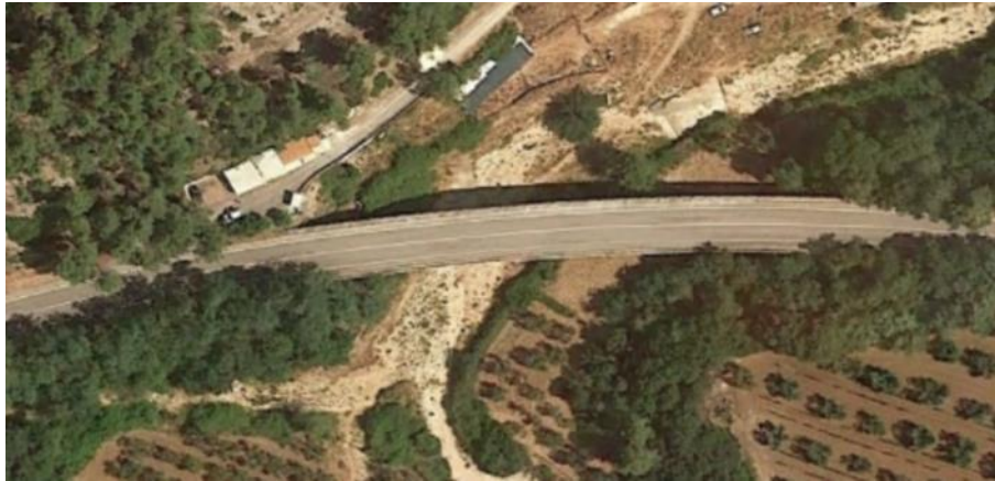
Figura 4-47: Viadotto a 5 campate
