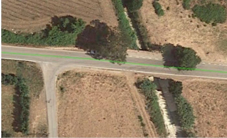
Figura 4-45: Ponte sul torrente Calenella
