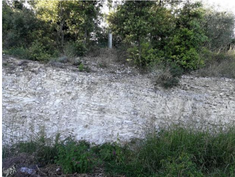
Figura 4-97 Affioramento di roccia calcarea (Maiolica 1) sui limiti di una delle strade di crinale del sistema dei Valloni che caratterizzano il primo tratto di sviluppo dell'infrastruttura. Si nota il cromatismo molto chiaro della roccia (sopralluogo effettuato a luglio 2022)
