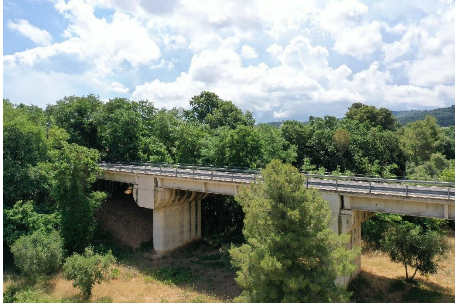
Figura 9.7: Vista viadotto Macchia esistente.
