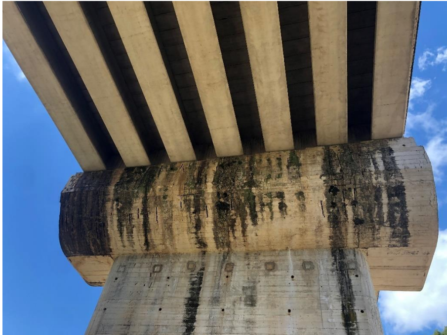
Figura 9.8: Particolare travi impalcato.
