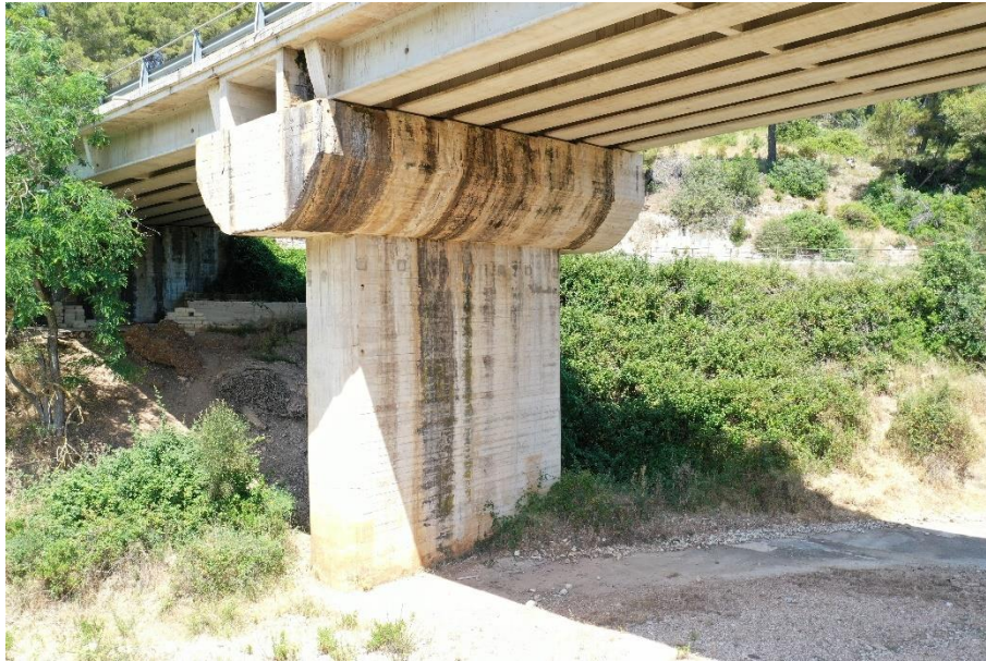
Figura 9.9: Particolare pila e pulvino.
