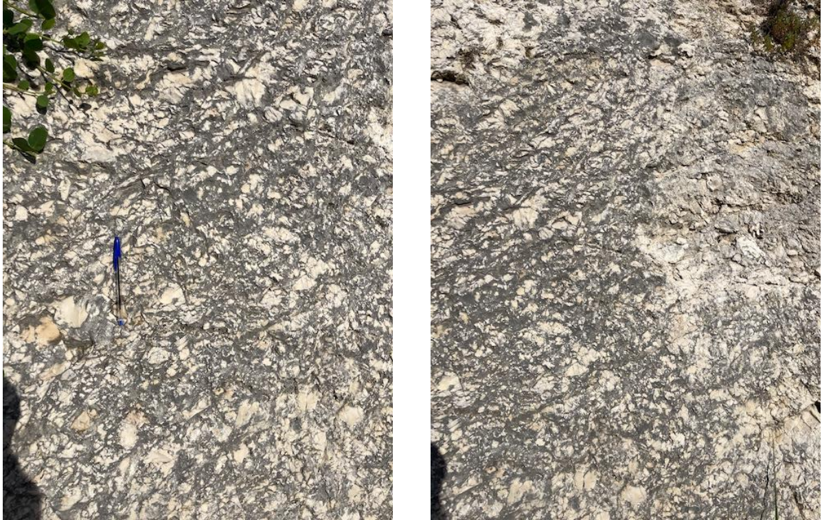
Figura 6.12: Unità geotecnica Ce2 – Sg1 (sinistra), Sg2 (destra).
