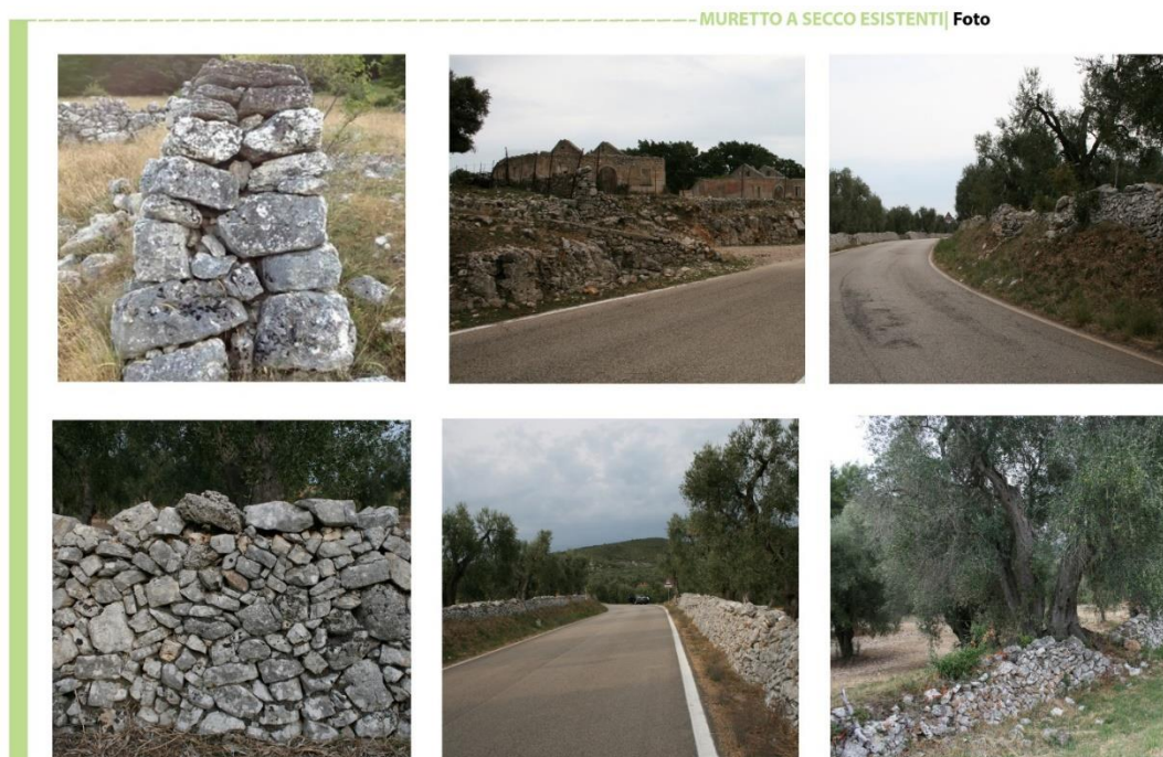
Figura 65 – Muretti a secco esistenti nei luoghi di progetto
