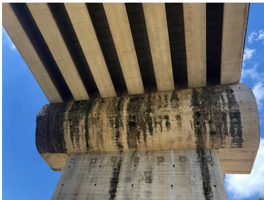
Figura 46 – Particolare travi impalcato del Viadotto Macchia allo stato attuale
