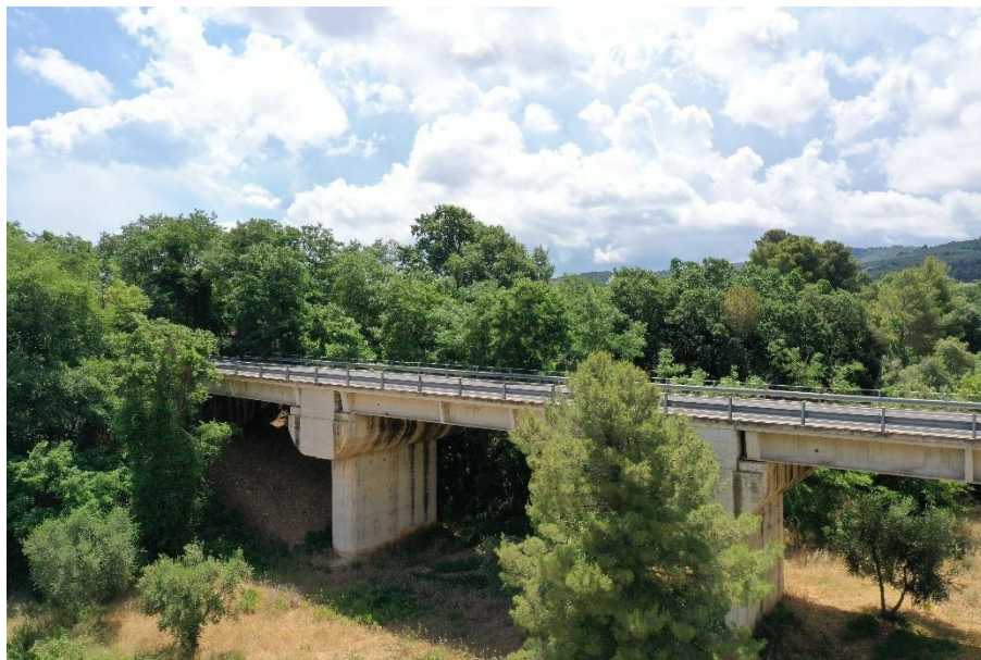
Figura 45 – Vista viadotto Macchia esistente
