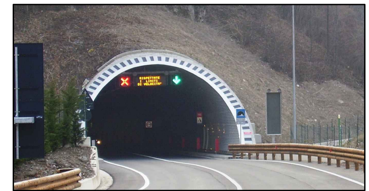
Esempio di impianti tecnologici in galleria
