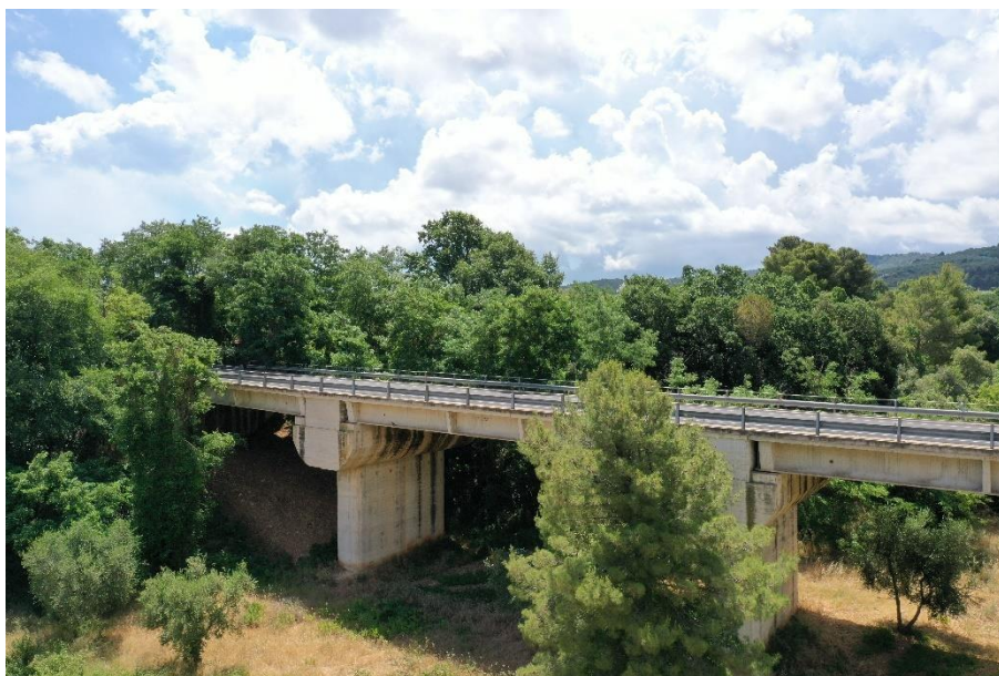
Figura 3 – Vista viadotto Macchia esistente
