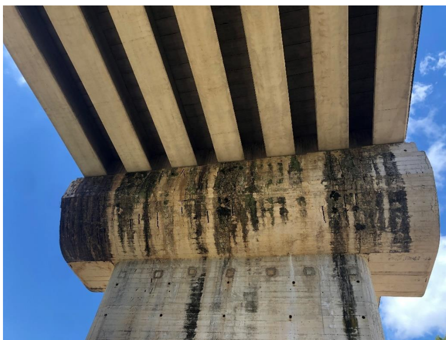
Figura 4 – Particolare travi impalcato
