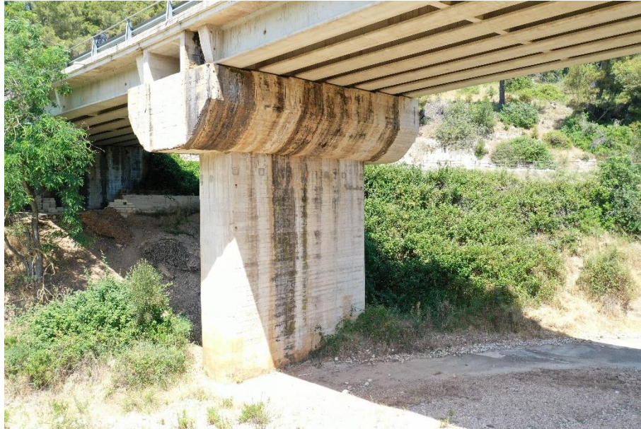
Figura 5 – Particolare pila e pulvino
