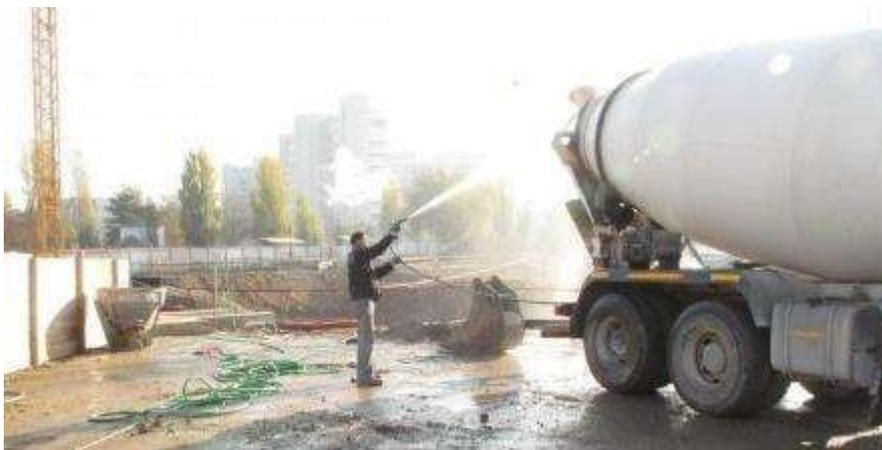
Figura 6-7. esempio di lavaggio del mezzo di cantiere
