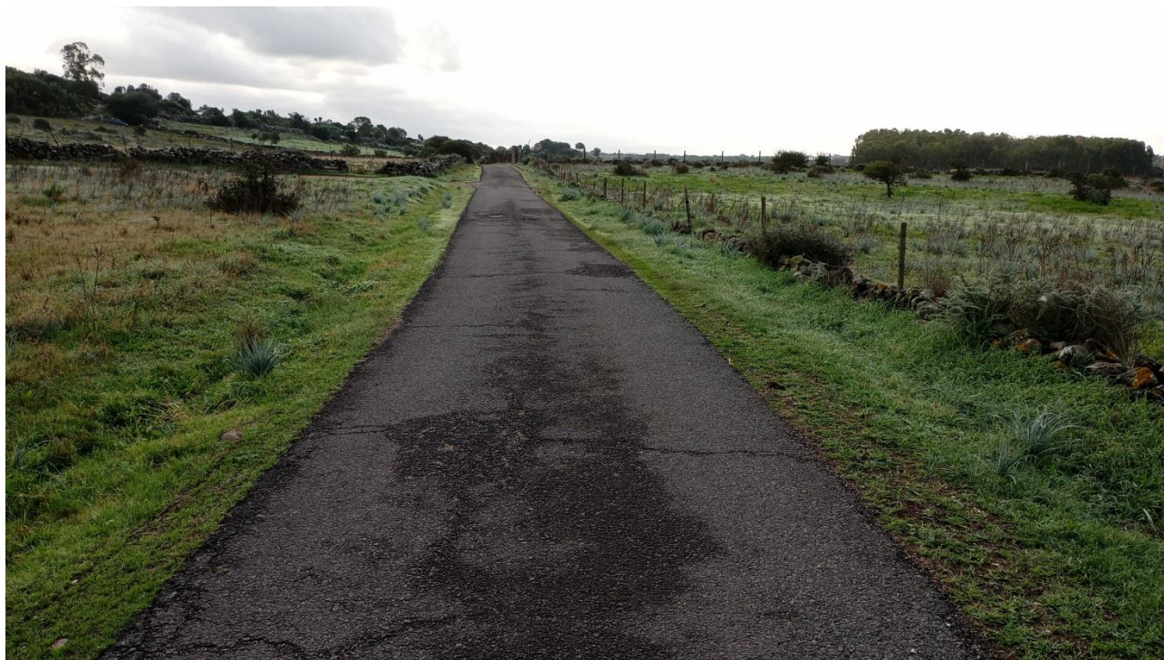
Figura 5-2 Tracciato esistente di accesso al parco eolico (direzione nord-ovest)
