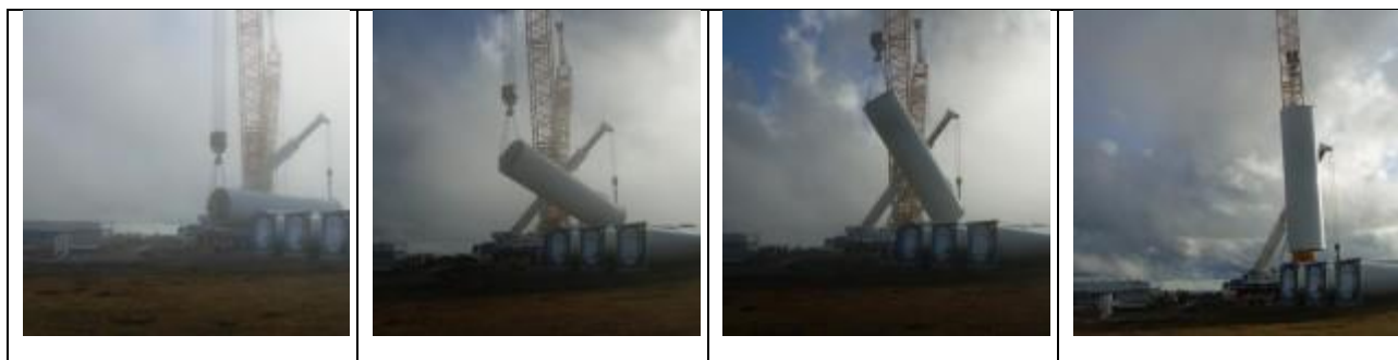
Figura 5-27 – Schema delle fasi di sollevamento dei componenti dell'aerogeneratore (Fonte sito web http://www.windfarmbop.com/ )
