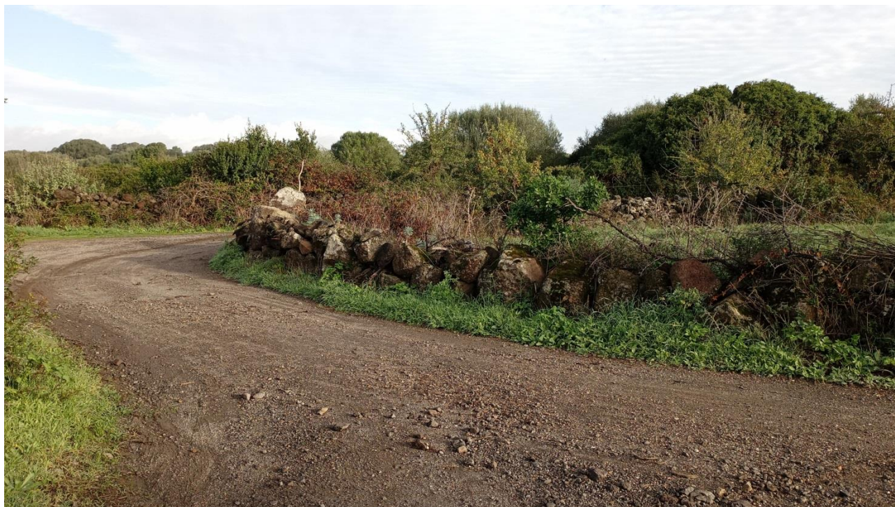
Figura 5-3 Tratturo di viabilità esistente di accesso al parco eolico (direzione nord)
