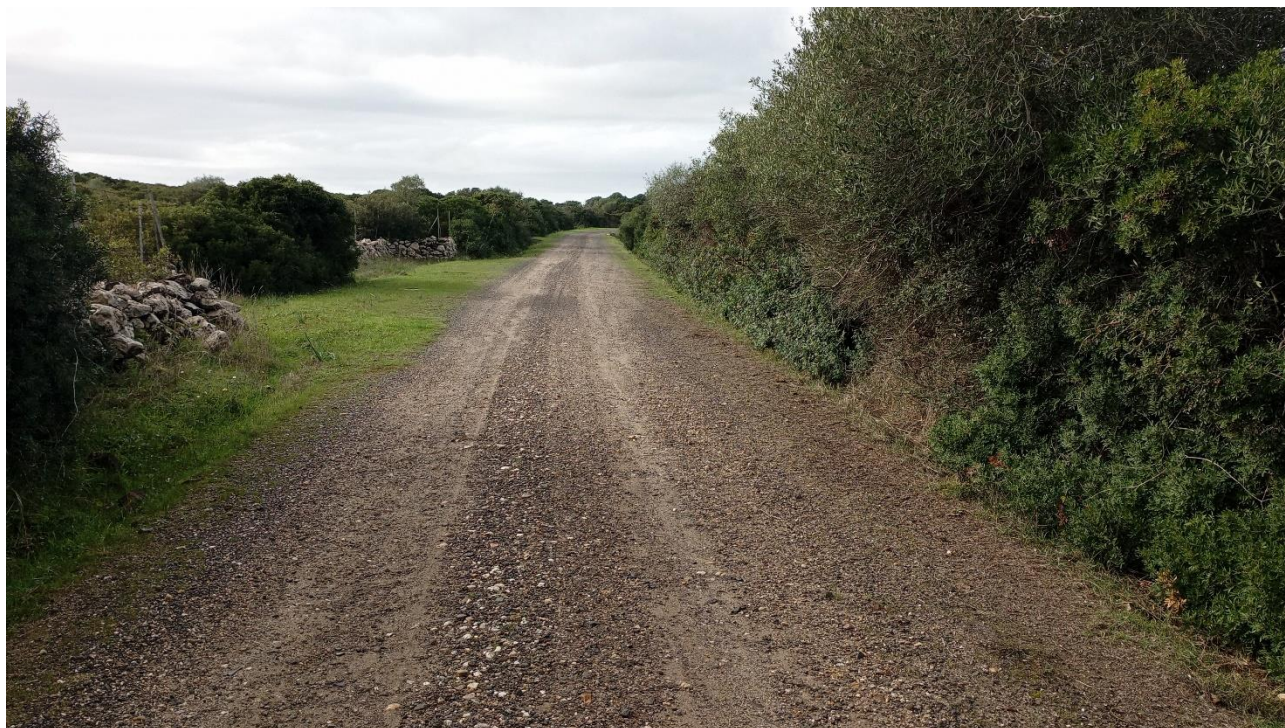
Figura 5-6 – Tratturo di viabilità esistente lungo il tracciato di accesso alla postazione BA03 facente parte della viabilità di progetto (vista verso est)
