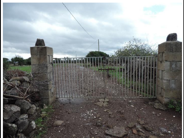
Cancello privato e stradello di avvicinamento a PA06
