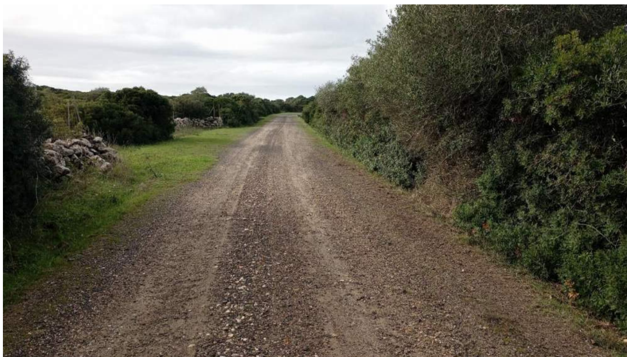
Figura 9.25 – Tratturo di viabilità esistente lungo il tracciato di accesso alla postazione BA03 facente parte della viabilità di progetto (vista verso est)
