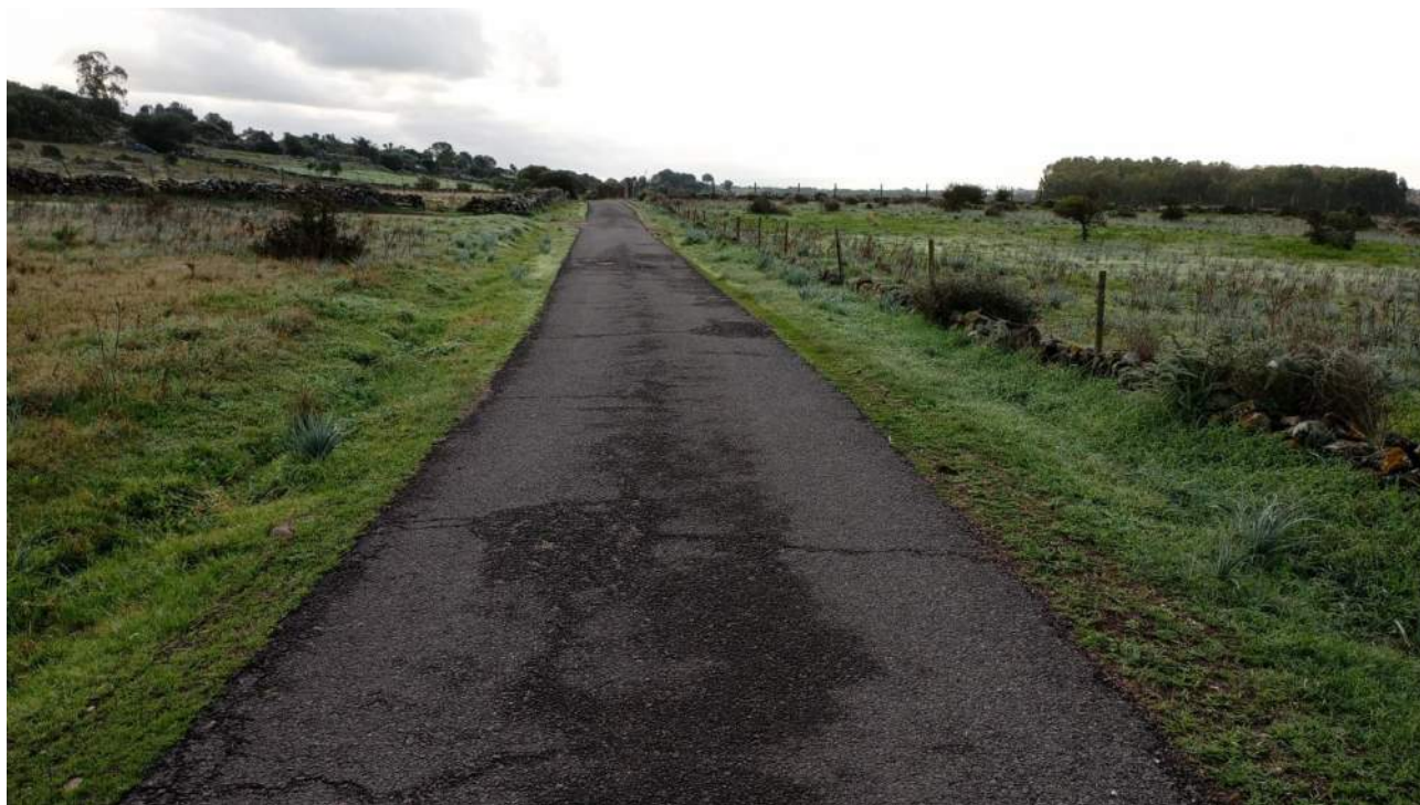
Figura 9.21 Tracciato esistente di accesso al parco eolico (direzione nord-ovest)
