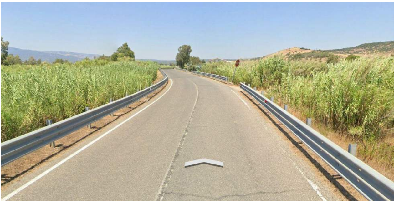
Figura 9.20 – Strada “Complanare est” di connessione con la rete stradale dell’area agricola di Bauladu
