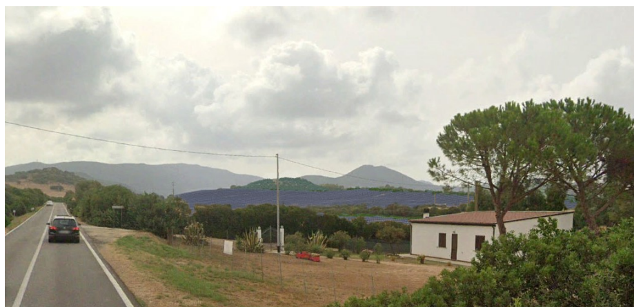
Figura 25 – Esempio vista post operam dell'impianto FV_TEULADA
