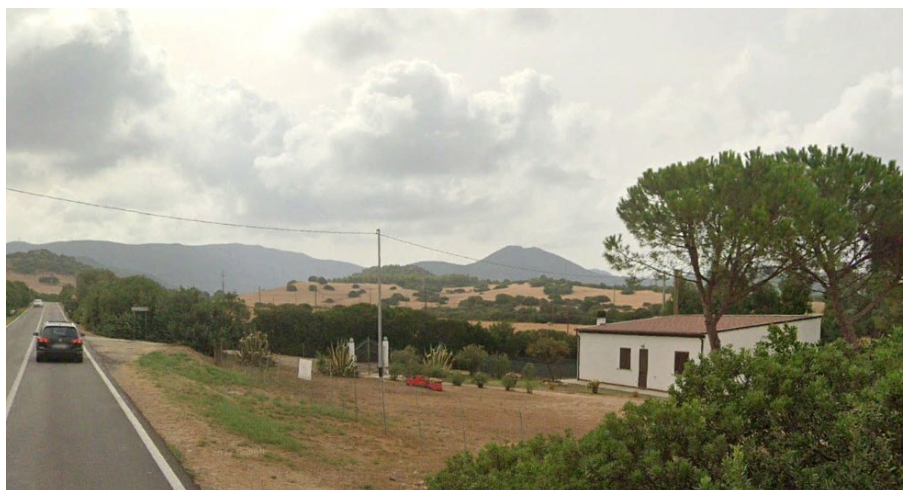
Figura 24 – Esempio vista ante-operam dell'impianto FV_TEULADA
